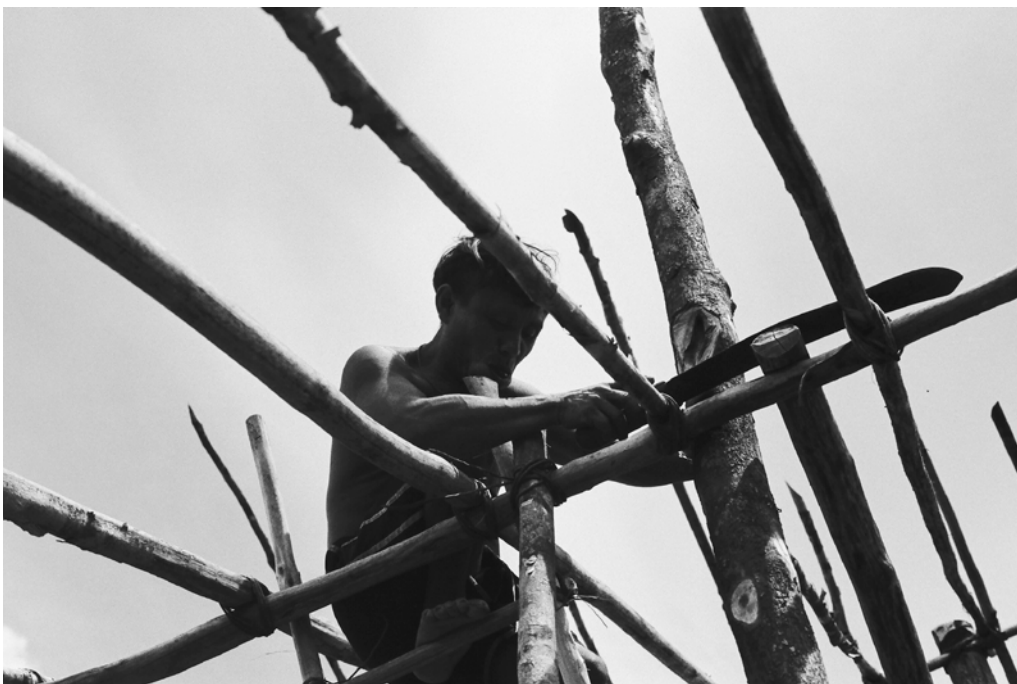
Fig. 36/37. Acima, nó de cipó em “X” ( okaoyakiraorewē ) entre a viga transversal ( rereorewē ) e o tirante da tesoura da cobertura ( payihiorewē ), com a solução das folhas de ubim ( komixē ) colocadas em linhas de cipós. Abaixo, colocação e amarração dos caibros ( hōrōhōrōma ) sobre viga de cumeeira ( pariparima ). Ambas, no novo xapono Pukima Beira (Daniel Jabra, 2016).
