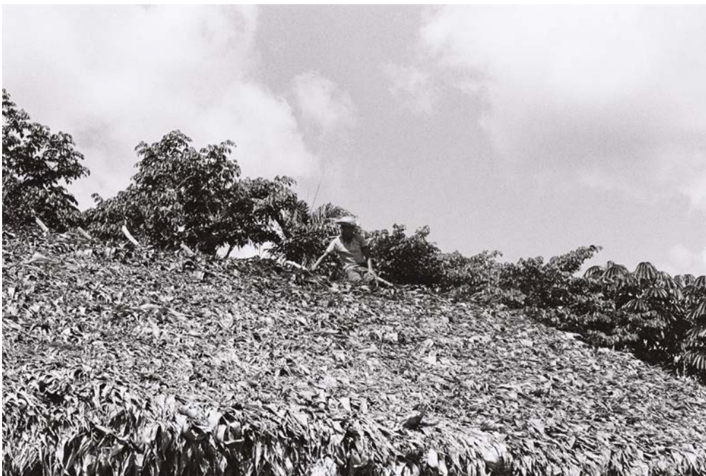
Fig. 39/40. Acima, linhas de cipó sendo colocadas na cobertura de uma casa em obras no xapono Pukima Cachoeira (2019). Abaixo, Crispinho, trabalhando na cumeeira da casa de Cândido, seu avô, e completando a colocação de palhas na cobertura da grande casa, no xapono Pukima Cachoeira (fotografia de Daniel Jabra, 2019).
